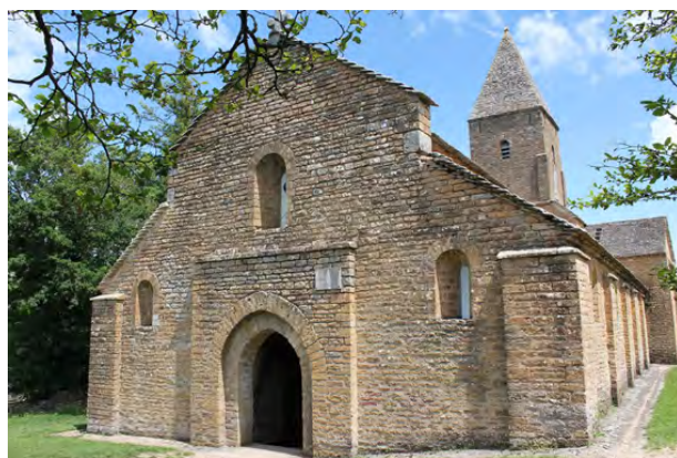
L'église de Brancion à Martailly-lès-Brancion (© CEP)
