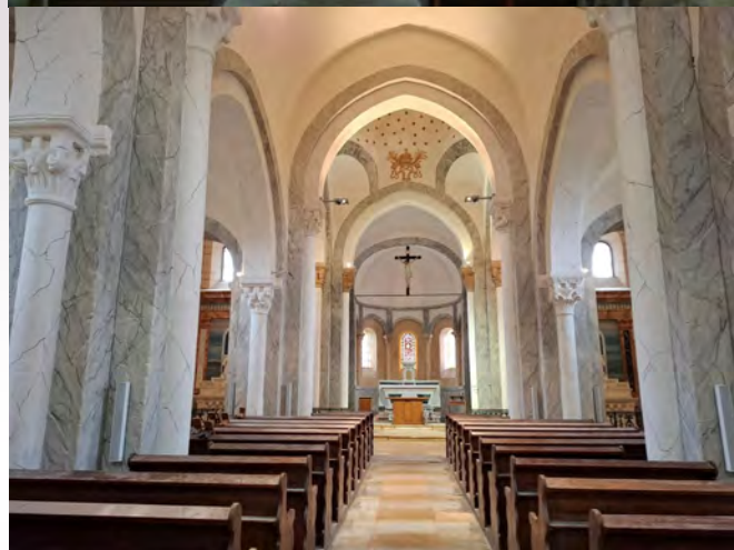
La nef de l'église avant et après la restauration (©ASEVA)
