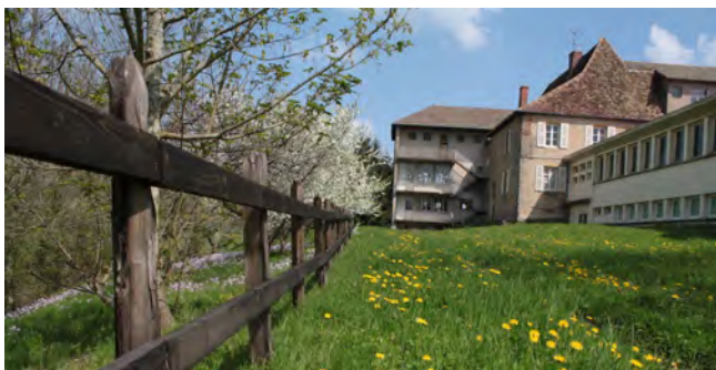
Le bâtiment du Montsac au printemps (© CEP)
